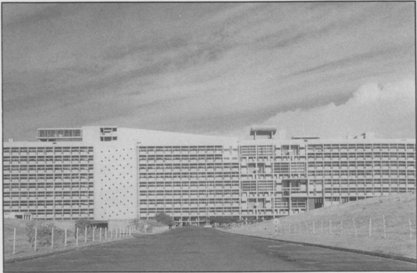
Figure 4. Chandigarh: Secretariat. Copyright Fondation Le Corbusier: FLC L3(12)18.
